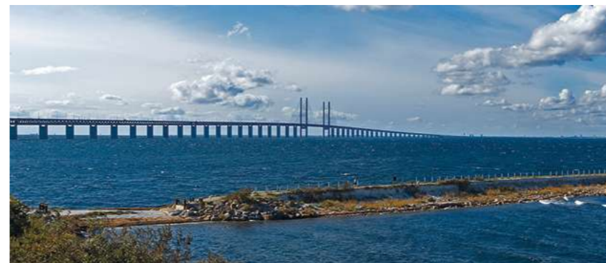
Die gewaltige, knapp 8 Kilometer lange Öresund-Brücke verbindet Dänemark mit Schweden.
