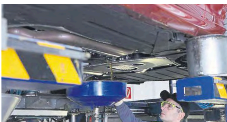
Sofern vorhanden, wird im RDZ als erstes die Hochvoltbatterie aus dem Fahrzeug entfernt. Fotos: BMW Group
