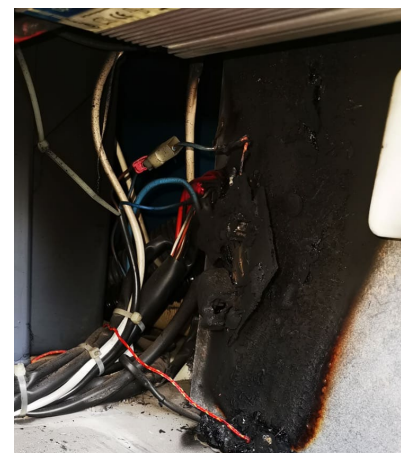
Die Reste eines automatischen Batterietrennschalters. Die Zuleitungen waren nicht abgesichert. Foto: Ade Berzl
