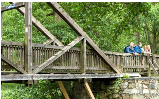
Selbitzbrücke am Rennsteig, Blankenstein
