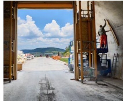
Nach Reparaturarbeiten an der Betonschale wird die gesamte Tunneltechnik getauscht
