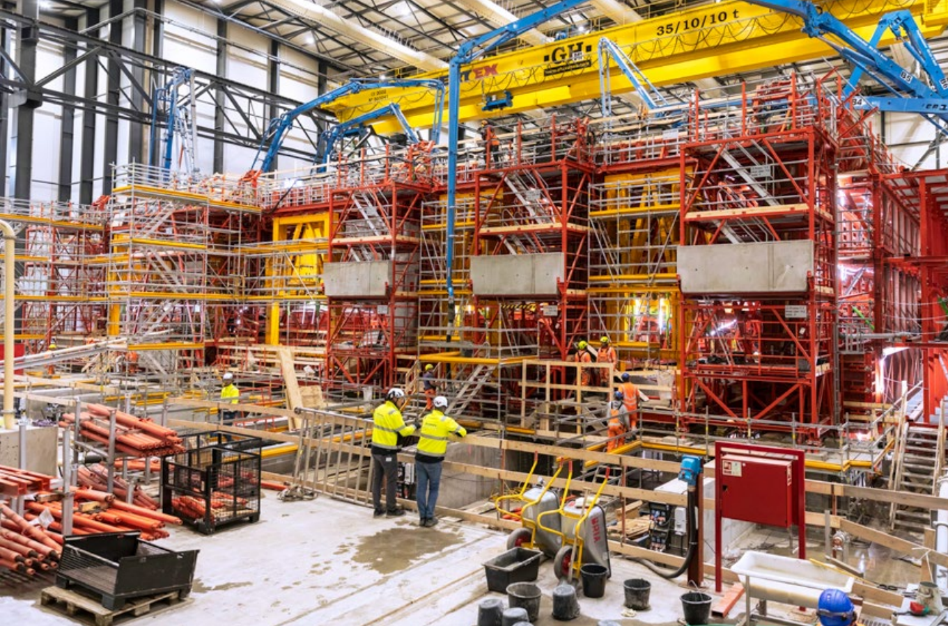
Auf sechs Produktionslinien entstehen in Rødbyhavn in einer eigens aufgebauten Betonfabrik die Segmente für den Tunnel. Mit tonnen-schweren Schotten abgedichtet, werden sie schwimmend zur Absenkposition geschleppt
