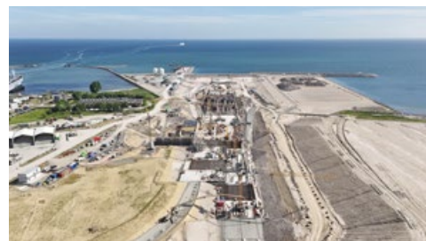
Vier Röhren in etwa 40 Metern Tiefe Zwei Eisenbahngleise und vier Autobahnspuren, je zwei in einer Fahrtrichtung mit durchgehendem Seitenstreifen. Die Tunnelzufahrt (rechts) in Puttgarden nimmt Gestalt an
