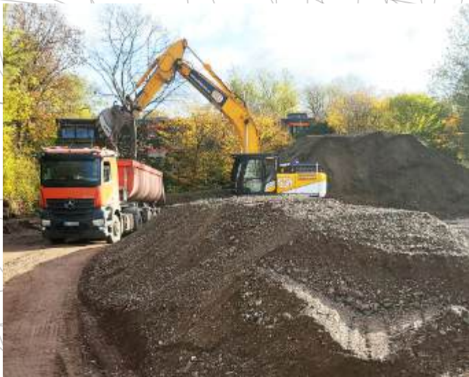
Die vorbereitenden Maßnahmen für die neue ADAC Geschäftsstelle in Minden sind gestartet
