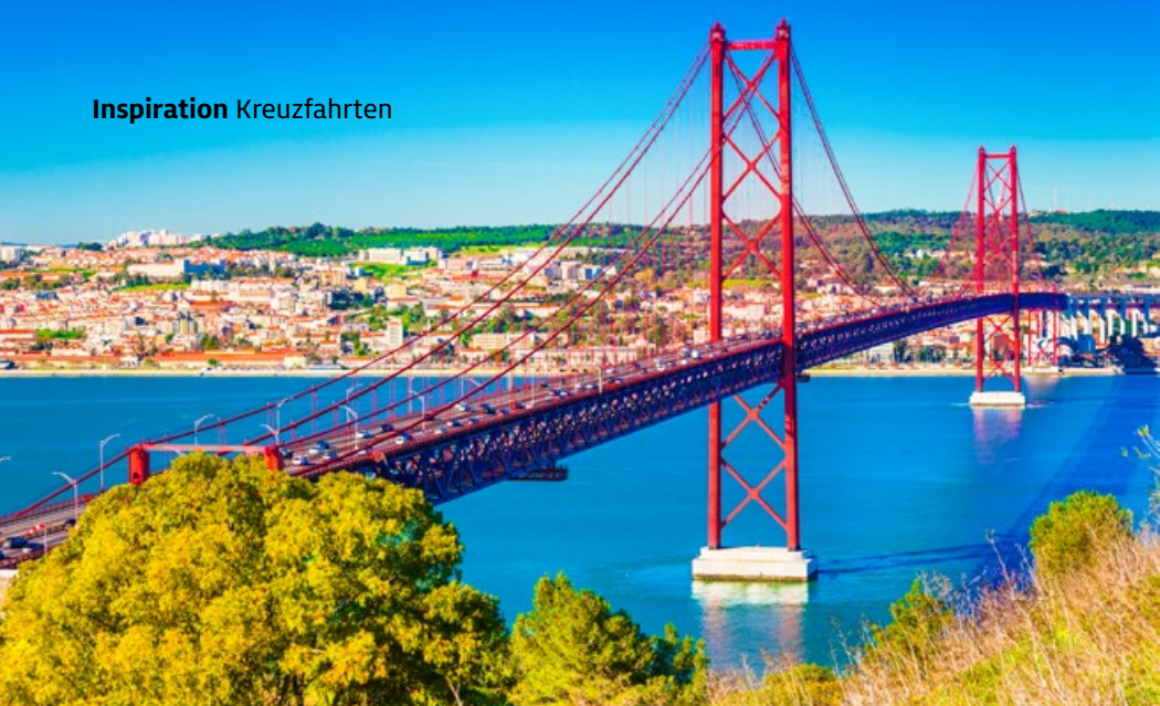
Endstation Lissabon Die Hängebrücke Ponte 25 de Abril spannt sich über den Tejo
